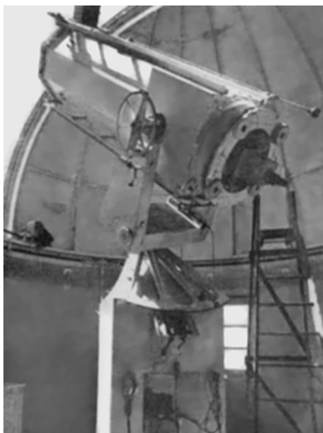
60-см зеркальный телескоп Т-60. 1950-е гг. Из архива обсерватории
