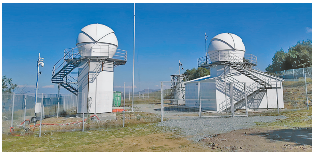
Комплекс роботизированных телескопов с диаметрами зеркальных объективов 0.5 метра. Предназначен для проведения массовых наблюдений с целью тайминга транзитов известных экзопланет, чтобы детектировать новые экзопланеты. Фотография из личного архива Г.Г. Валявина, руководителя группы изучения экзопланет САО РАН
