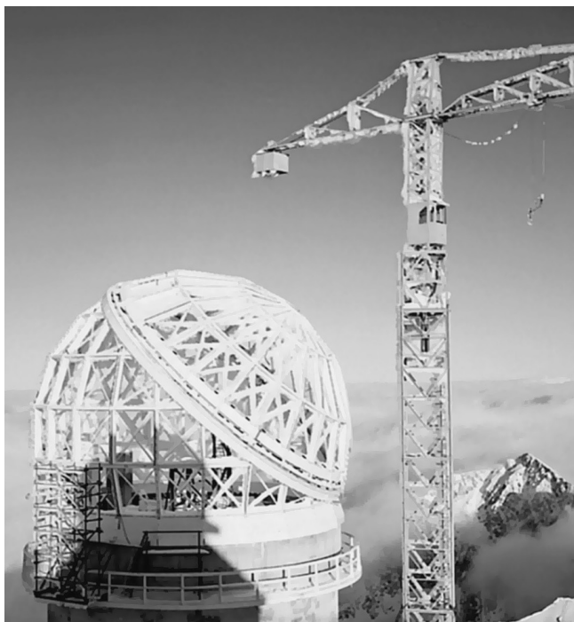
Строительство башни телескопа им. Бернара Лио. 1974 г. Из архива обсерватории
