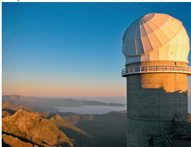
Башня с 20-см рефлектором и внезатменным коронографом Бернара Лио
