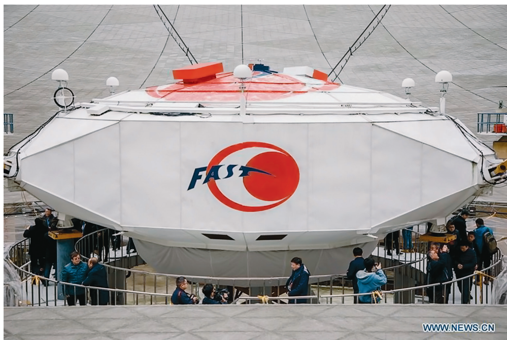
Кабина облучателей и приемников опущена в центральный проем. Фотография новостного портала www.news.cn
